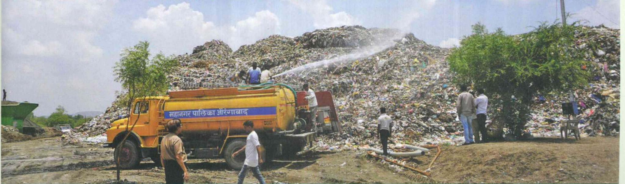
जैविक सामग्री टाकण्याचे काम झाले, की मग अशाप्रकारे अग्निशमन बंधाच्या साहाय्याने कचऱ्याच्या डोंगरावर चहुबाजूंनी पाणी फवारले जाई.
