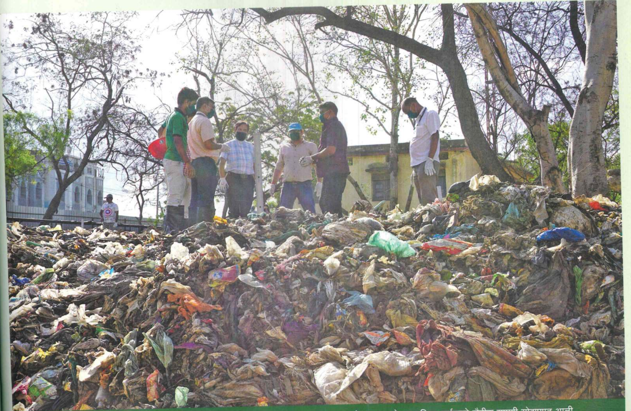
सेंट्रल नाका येथील कचऱ्यावर वायुवीजन पद्धतीचा वापर. कचऱ्यावर पठार करून त्यावर खोलवर टाकलेल्या सच्छिद्र पाईपद्वारे जैवीक सामग्री सोडण्यात आली.
