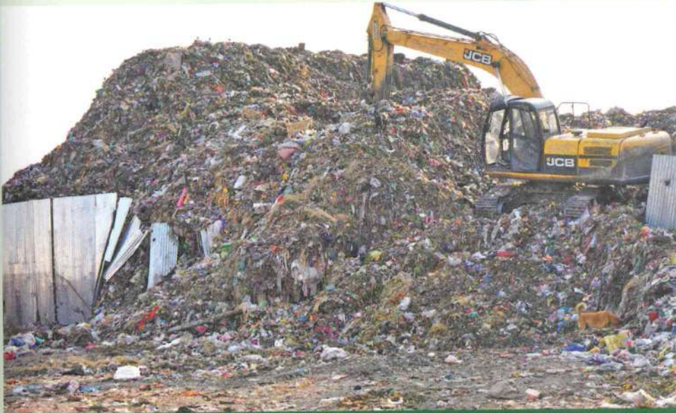
जैविक प्रक्रिया करण्याआधी जेसीबी मशिनच्या साहाय्याने कचरा असा एका बाजूला व्यवस्थित लावण्यात आला.
